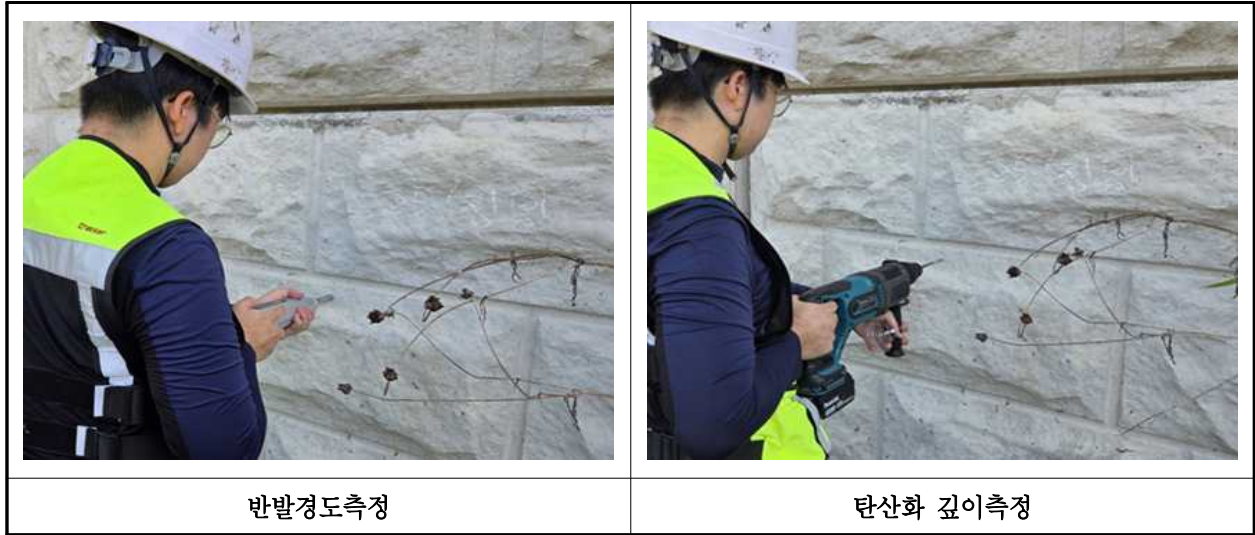
【사진 7.4.1】 재료시험 조사 전경
