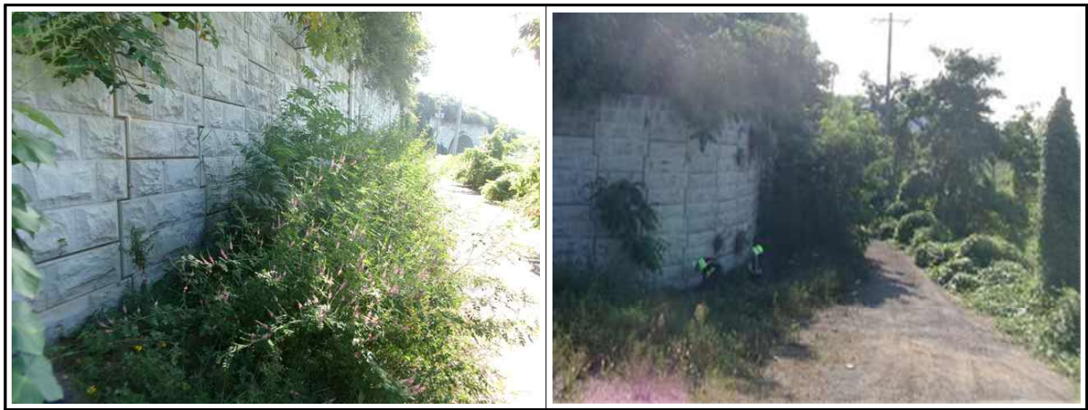
【사진 7.3.1】 지반, 기초부 전경
