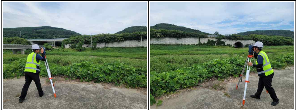
【사진 7.4.2】 측량작업 전경
